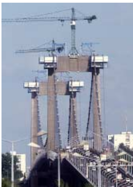
Têtes de pylônes en cours de renforcement
