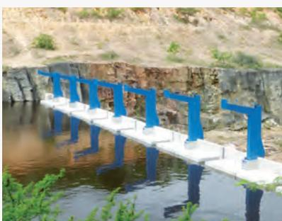
Après la sévère sécheresse de 2012, l'État de Bahia au Brésil a choisi la technologie des hausses fusibles afin d'augmenter de 7 millions de m<sup>3</sup> (+ 30%), la capacité de stockage du barrage de França. Le projet clé en main (études, travaux préparatoires, fourniture et pose) a été réalisé par Hydroplus® en 10 mois.
