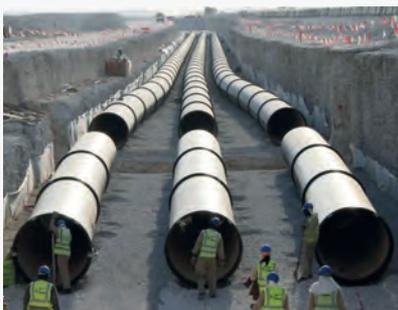
Située à 25 km de Doha, la station de pompage PS70, avec un débit de 680 000 m<sup>3</sup>/jour, est la plus importante station de ce type construite au Moyen-Orient. Le contrat couvre la conception, la construction et la mise en route d'un puits de dégrillage, d'un puits de relevage, d'une station
